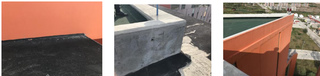
FALLA DE TENSION DIAGONAL EN VIGAS DE ACOPLAMIENTO EN MUROS DE CORTANTE EN CORONA Y ASENTAMIENTOS DIFERENCIALES POR FUERZAS DE CORTANTES OCASIONADOS POR EL SISMO
