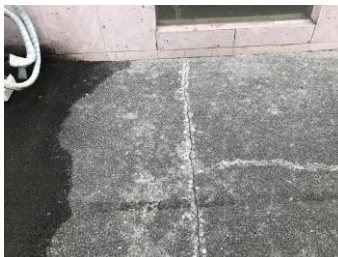
CONTINUACION DE GRIETA FALLA DE TENSION DIAGONAL EN VIGAS DE ACOPLAMIENTO EN MUROS DE CORTANTE Y ASENTAMIENTOS DIFERENCIALES POR FUERZAS DE CORTANTES OCASIONADOS POR EL SISMO
