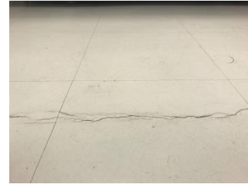
VISTA GENERAL DE GRIETA POR FALLA DE TENSION DIAGONAL EN VIGAS DE ACOPLAMIENTO EN MUROS DE CORTANTE Y ASENTAMIENTOS DIFERENCIALES POR FUERZAS DE CORTANTES OCASIONADOS EN PISO POR EL SISMO EN EL AREA DE LABORATORIO GENERAL DEL HGR
