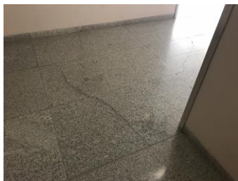
FALLA DE TENSION DIAGONAL EN VIGAS DE ACOPLAMIENTO EN MUROS DE CORTANTE Y ASENTAMIENTOS DIFERENCIALES EN PISOS POR FUERZAS DE CORTANTES OCASIONADOS POR EL SISMO
