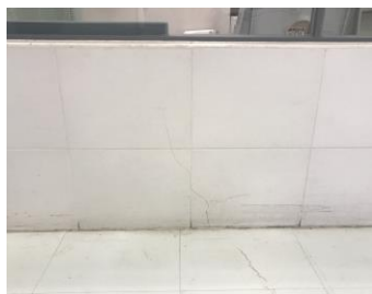
CONTINUACION DE GRIETA FALLA DE TENSION DIAGONAL EN VIGAS DE ACOPLAMIENTO EN MUROS DE CORTANTE Y ASENTAMIENTOS DIFERENCIALES POR FUERZAS DE CORTANTES OCASIONADOS POR EL SISMO
