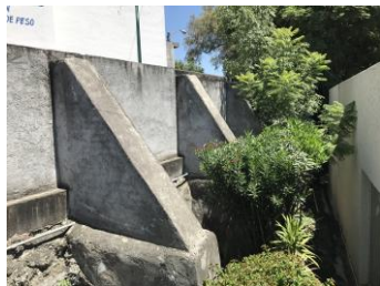
DETALLE DE CONTRAFUERTE CON MURO DE CONTENCION Y VISTA GENERAL DE LOSAS DE CUBIERTA CON TRABES Y PRETILES EN GENERAL
