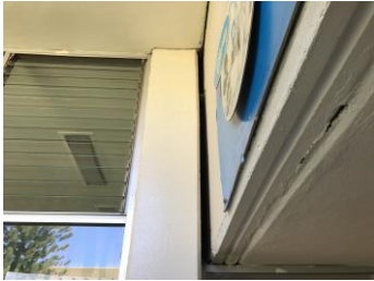
DETALLE DE JUNTA CONSTRUCTIVA COLUMNA DE CARGA PRINCIPAL Y LOSA DE ENTREPISO, CUBOS DE ESCALERAS PERSONAL DE SERVICIO IMSS
