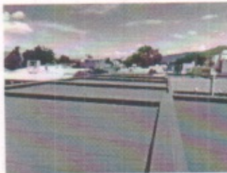
VISTA GENERAL DE ESTRUCTURACION DE LOSA DE CUBIERTA EN GENERAL CON TRABES DE CARGA PRINCIPAL
