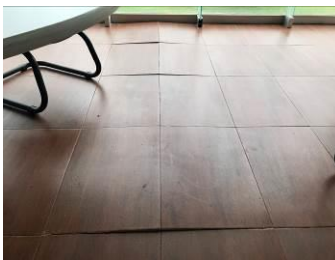
DETALLE DE LEVANTAMIENTO DE REVESTIMIENTO DE LOSETA EN PISO POR ASENTAMIENTO DIFERENCIAL POR CARGAS DE CORTANTE OCASIONADOS POR EL SISMO Y SANITARIO GENERAL COMEDOR
