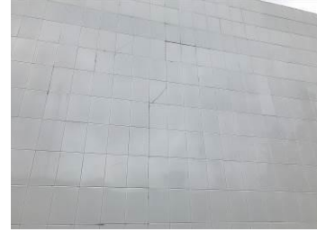
FALLA DE TENSION DIAGONAL EN VIGAS DE ACOPLAMIENTO EN MUROS DE CORTANTE Y ASENTAMIENTOS DIFERENCIALES POR FUERZAS DE CORTANTES OCASIONADOS POR EL SISMO EDIFICIO DE INVESTIGACION
