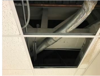
DETALLE DE ESTRUCTURA DE ACERO CON LOSACERO Y AREA DE DIRECCION GENERAL EN SEGUNDO NIVEL
