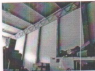
DETALLE GENERAL DE ESTRUCTURACION DE COLUMNAS Y APOYOS SECUNDARIOS DE REFUERZO EN MUROS DE CARGA PERIMETRALES, ASI COMO MONTENES Y TRABES DE ACERO, PARA RECIBIR CUBIERTA DE LAMINAS DE ACERO EN NAVE PRINCIPAL
