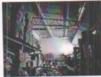
DETALLE DE ALMACEN PRINCIPAL Y ANDENES DE CARGA, ESTRUCTURADO Y REFORZADO CON MONTENES Y ACERO CUADRADO EN ESTRUCTURA PRINCIPAL DE ACERO
