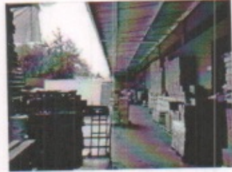
DETALLE DE ALMACEN PRINCIPAL Y ANDENES DE CARGA, ESTRUCTURADO Y REFORZADO CON MONTENES Y ACERO CUADRADO EN ESTRUCTURA PRINCIPAL DE ACERO
