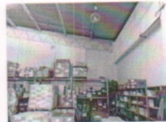
VISTA GENERAL DE ANDENES, ALMACEN CON CUBIERTA DE MULTIPANEL TERMICO ACABADO DE METAL AMBAS CARAS, CON MONTEN, CELOSIA TIPO HOWE Y ATIRANTADO DE ACERO REDONDO
