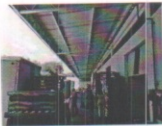
VISTA GENERAL DE ANDENES, ALMACEN CON CUBIERTA DE MULTIPANEL TERMICO ACABADO DE METAL AMBAS CARAS, CON MONTEN, CELOSIA TIPO HOWE Y ATIRANTADO DE ACERO REDONDO
