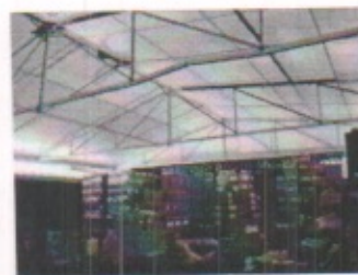
TOLDO ARMADO DE ESTRUCTURA DE ACERO CUDRADO Y CUBIERTA DE VINYL Y LAMINA DE ACERO EN ALMACEN EXTERIOR
