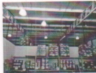
VISTA GENERAL DE ANDENES, ALMACEN CON CUBIERTA DE MULTIPANEL TERMICO ACABADO DE METAL AMBAS CARAS, CON MONTEN, CELOSIA TIPO HOWE Y ATIRANTADO DE ACERO REDONDO
