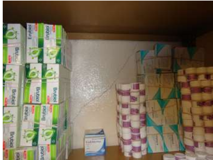
Foto 7. Fisura por asentamiento.
