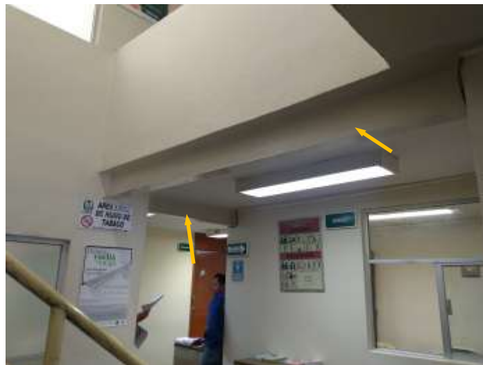
Foto 3. Vigas W (IR) de refuerzo
