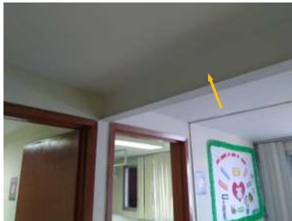
Foto 4. Vigas de acero de la UMF No. 80 Satélite
