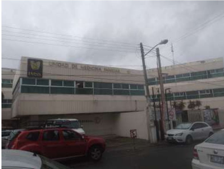
Foto 2. Vista de la Fachada Principal de la UMF No. 51 – Santa Mónica
