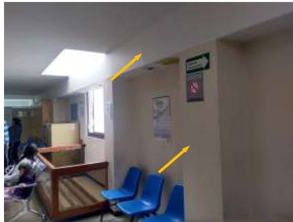
Foto 4. Travesaños y Columnas de concreto reforzado
