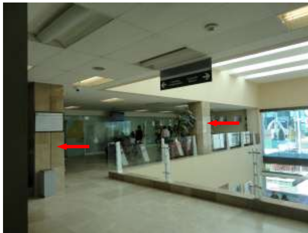
Foto 4. Columnas de concreto reforzado
