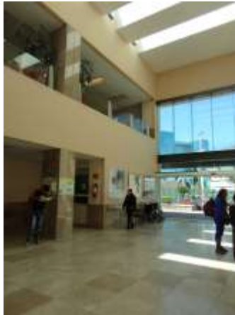
Foto 5. Vista interior de la UMF No. 250 – La Magdalena en completa operación. No se aprecia ningún tipo de daño estructural
