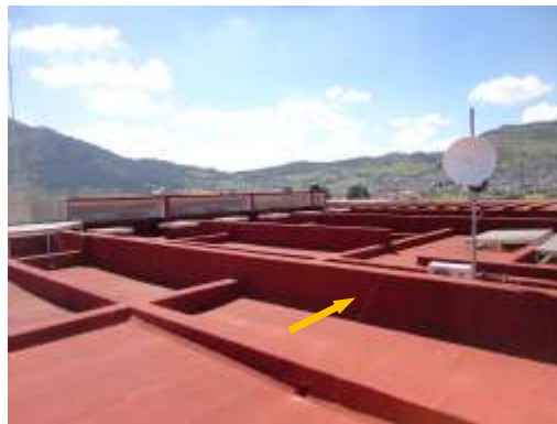
Foto 4. Traveses de concreto reforzado
