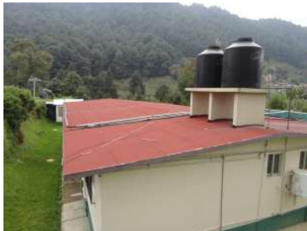
Foto 5. Vista de la cubierta de la UMF No. 247 – San Pedro Zictepec.
