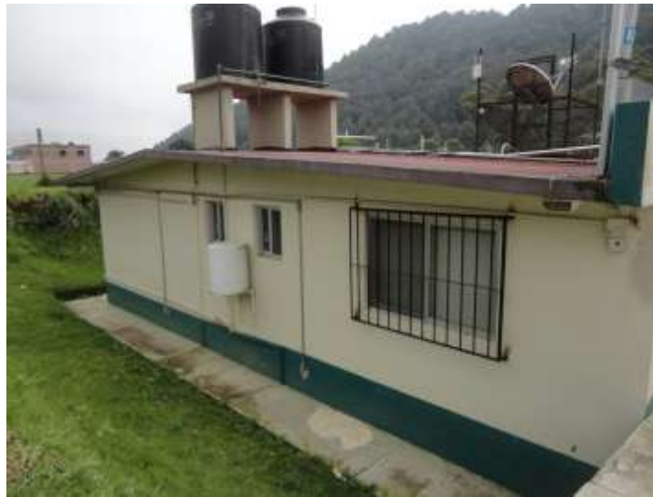
Foto 2. Vista exterior de la UMF No. 247 – San Pedro Zictepec
