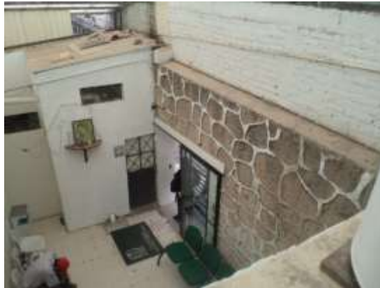
Foto 4. Vista de los muros de sillar de la UMF No. 245 Aculco
