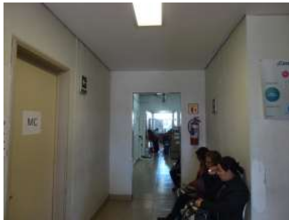
Foto 4. Muros de carga de la UMF No. 244 – FFCC Toluca
