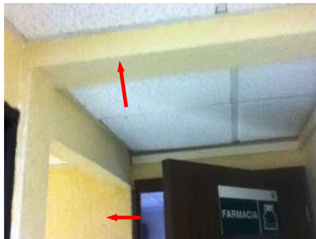
Foto 4. Muros de tabique y traveses de concreto
