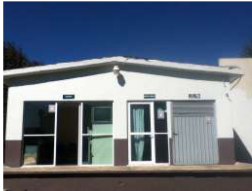
Foto 5. Vista posterior de la UMF No. 243 – Villa Victoria en completa operación. No se aprecia ningún tipo de daño estructural
