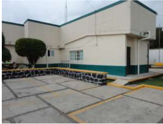
Foto 2. Vista exterior de la UMF No. 242 – Tenango de Arista
