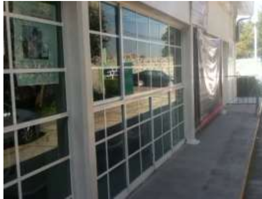
Foto 5. Vista interior de la UMF No. 241 – Temoaya en completa operación. No se aprecia ningún tipo de daño estructural
