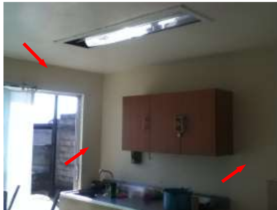
Foto 4. Muros de mampostería de tabique, columnas y traveses de concreto reforzado
