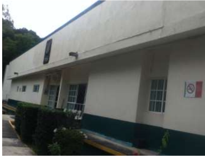
Foto 2. Vista exterior de la UMF No. 240 – Temascaltepec
