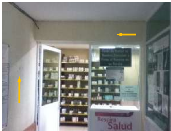
Foto 4. Muros de tabique y traveses de concreto
