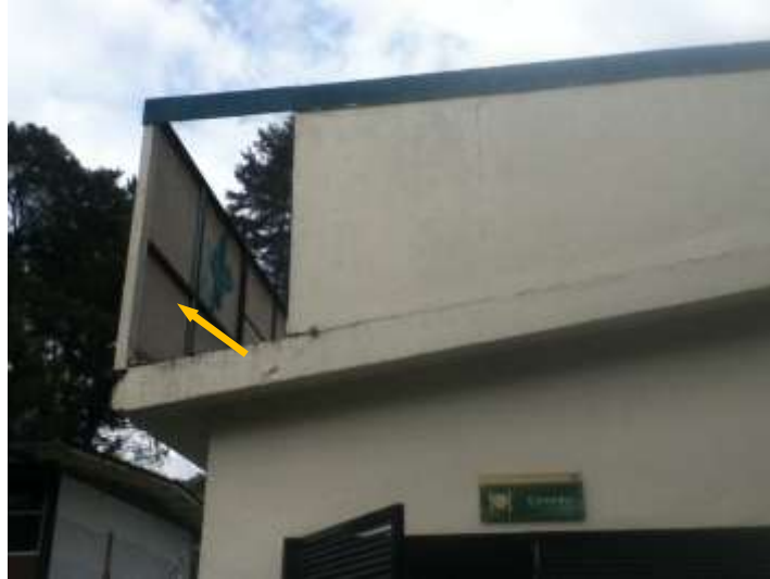
Foto 7. Faldón perimetral de durock
