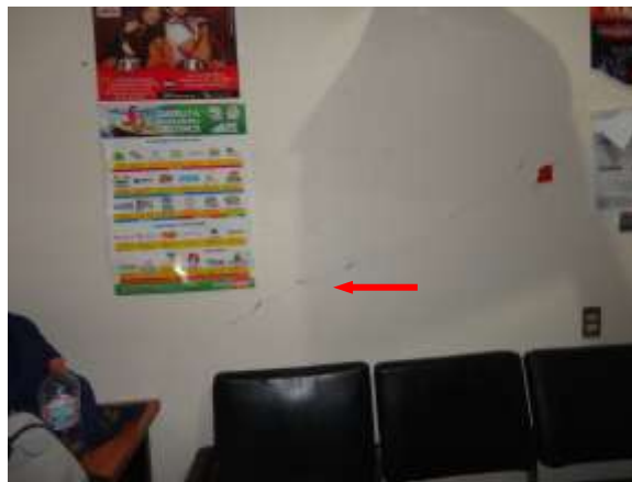
Foto 6. Vista interior de la UMF No. 232 – Villa Guerrero. No se aprecia ningún tipo de daño
