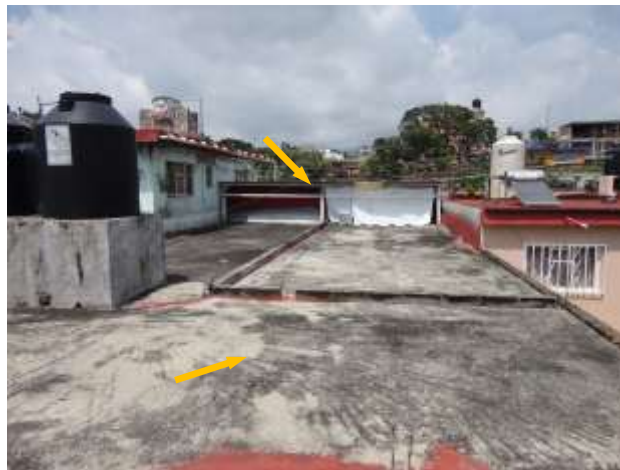
Foto 4. Vista de las cubiertas de concreto y lámina, de la UMF No. 232 – Villa Guerrero
