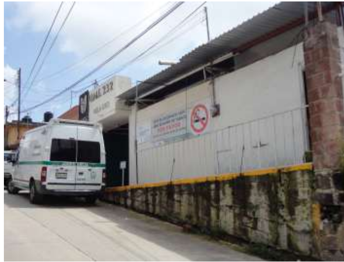
Foto 2. Vista de la cubierta de lámina de la UMF No. 232 – Villa Guerrero
