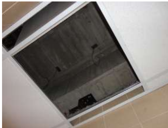
Foto 4. Trabe y losa de concreto de la UMF No. 231 – La Pilita
