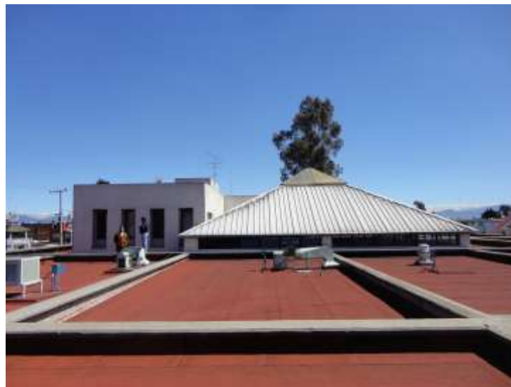
Foto 3. Cubierta de la UMF No. 231 - La Pilita
