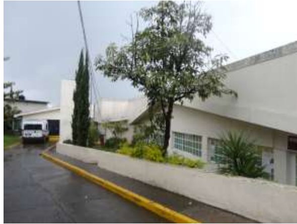
Foto 5. Vista exterior de la UMF No. 229 – Tenancingo. No se aprecia ningún tipo de daño
