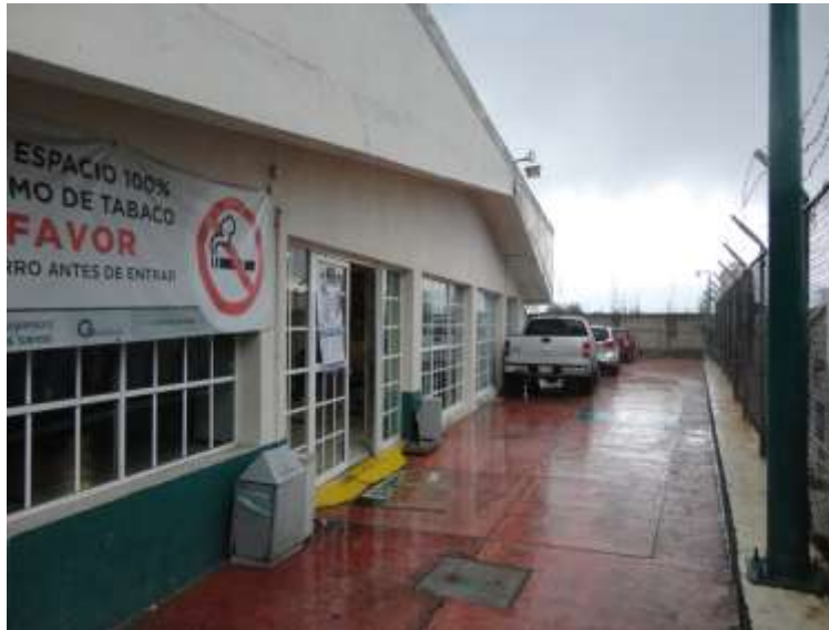
Foto 2. Vista exterior de la UMF No. 229 – Tenancingo
