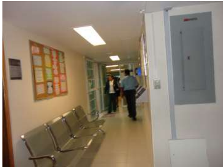
Foto 3. Vista interior de la UMF No. 229 – Tenancingo
