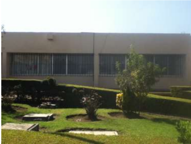
Foto 2. Vista exterior de la UMF No. 228 – Santiago Tianguistenco
