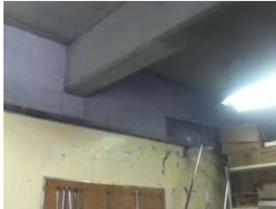
Foto 4. Trabes de concreto reforzado
