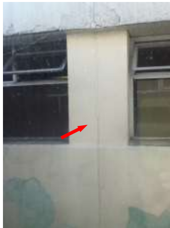
Foto 4. Columnas de concreto reforzado
