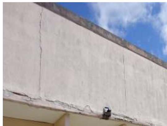
Foto 5. Fisuras en juntas de faldón perimetral.
