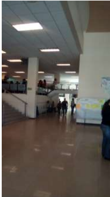
Foto 3. Vista del interior de la Unidad de Medicina Familiar (UMF) No. 222 - Toluca
