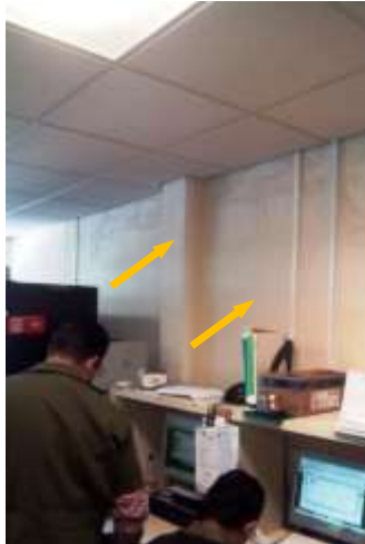
Foto 4. Vista de Columnas y Muros de concreto reforzado del edificio de FARMACIA de la (UMF) No. 222
