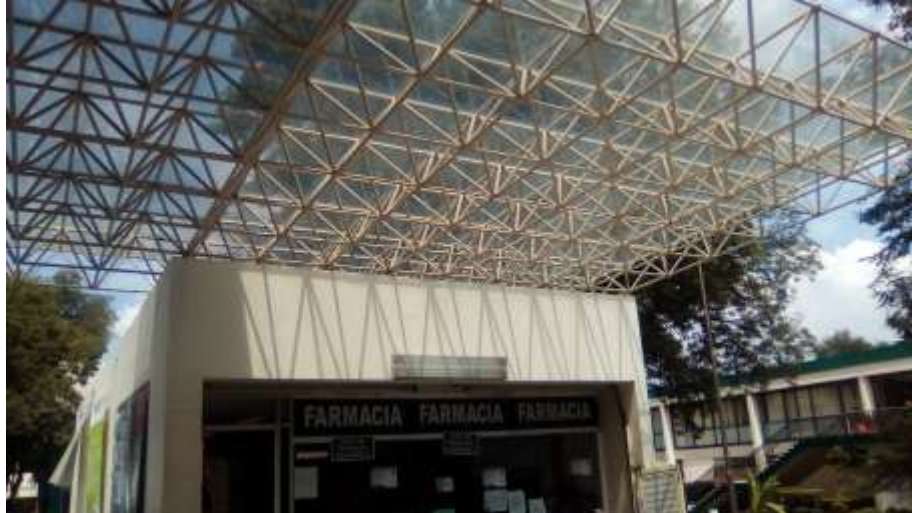
Foto 3. Vista de la fachada principal del Edificio de FARMACIA de la Unidad de Medicina Familiar No. 222. Exhibe una cubierta ligera a base de una armadura tridimensional de acero.
