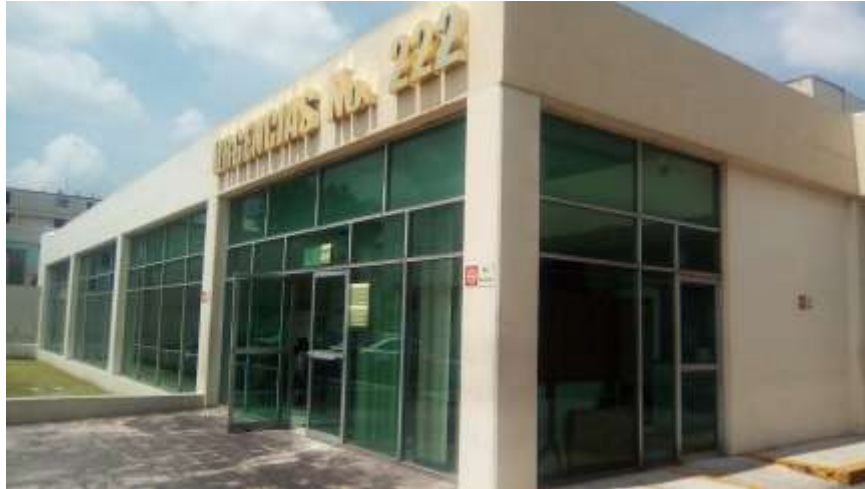
Foto 2. Vista de la Fachada Principal del Edificio de URGENCIAS de la Unidad de Medicina Familiar No. 222
