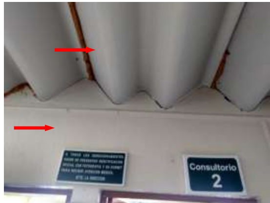
Foto 4. Muros de mampostería de tabique soportando la techumbre de lámina de asbesto
