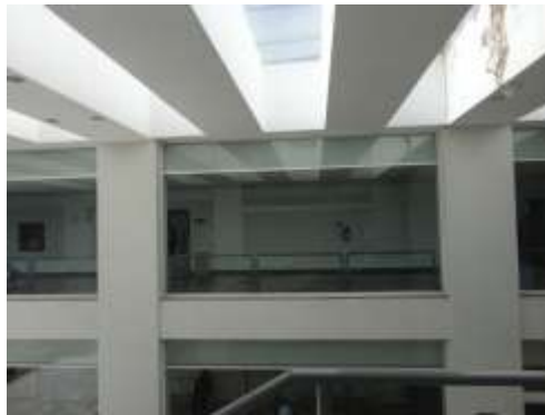
Foto 4. Columnas y Trabes de concreto de la UMAA No. 231 – Metepec
