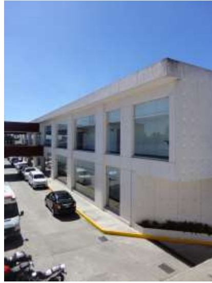
Foto 2. Vista exterior de la UMAA No. 231– Metepec
