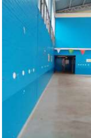
Foto 4. Vista de los muros perimetrales. Sin daño.
