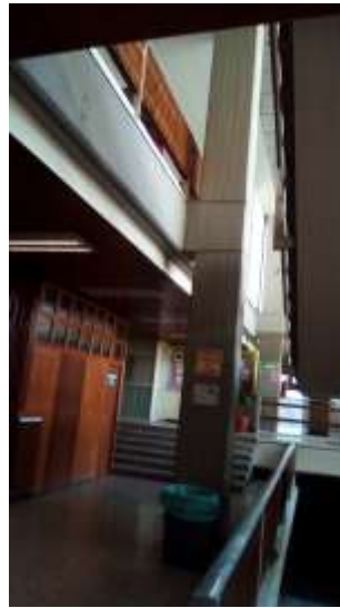
Foto 4. Columnas y Trabes de concreto reforzado del CSST
