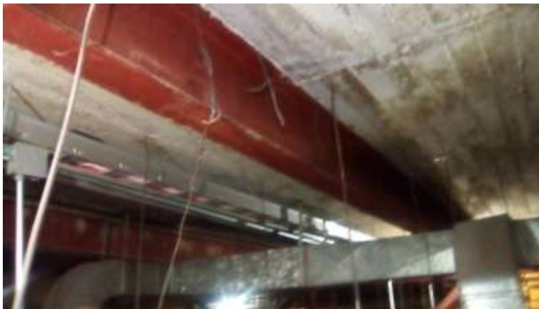
Foto 5. Vista de la losa de cubierta y viga de soporte del Teatro. No hay daño alguno.
