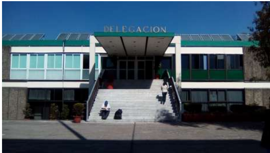
Foto 2. Vista de la Fachada Sur del Centro de Seguridad Social IMSS-Toluca
