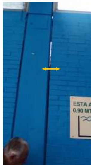
Foto 5. Junta constructiva de muro
