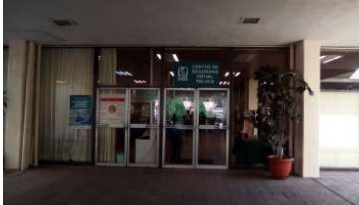
Foto 8. CSST en completa operación
