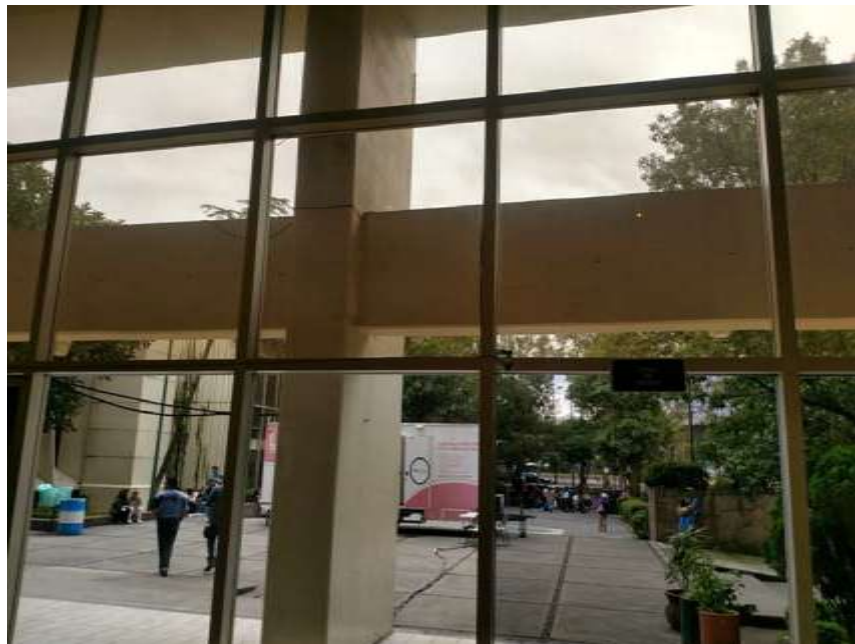
FOTOGRAFÍA 4. VISTA DE CANCELERÍA Y ESTRUCTURA.
