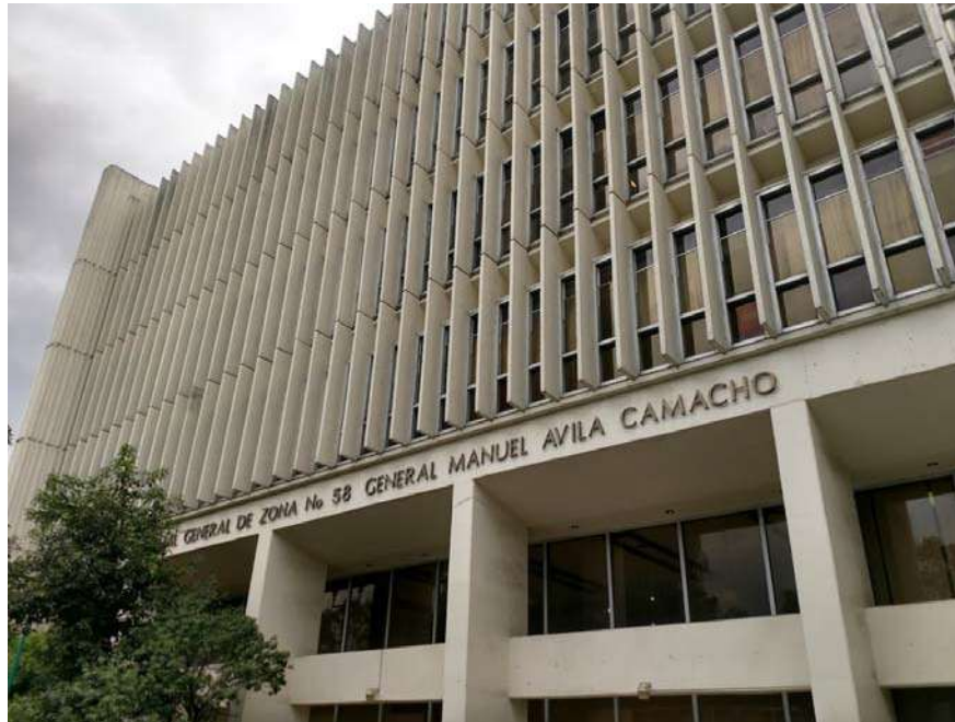
FOTOGRAFÍA 1. FACHADA PRINCIPAL HOSPITAL GENERAL DE ZONA NO. 58
