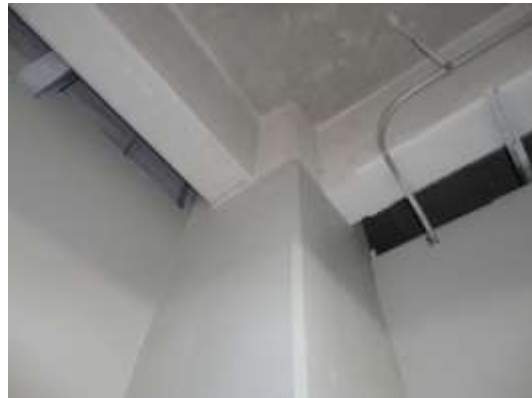
Foto 4. Vista de Columnas y Trabes de concreto reforzado del Hospital General Regional IMSS-HGR No. 251
