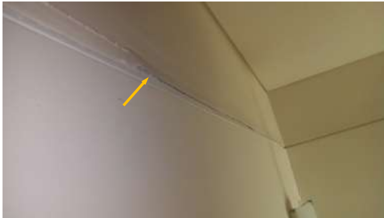
Foto 5. Fisura en Junta Constructiva (canaleta "u" de control recto de pvc para junta de expansión de paneles tablaroca o durock)
