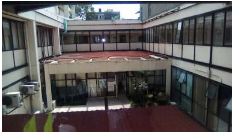
Foto 4. Vista de Columnas y Trabes de concreto reforzado del Hospital de Gineco-obstetricia No. 221 Dr. Emilio Chuayffet Chuayffet
