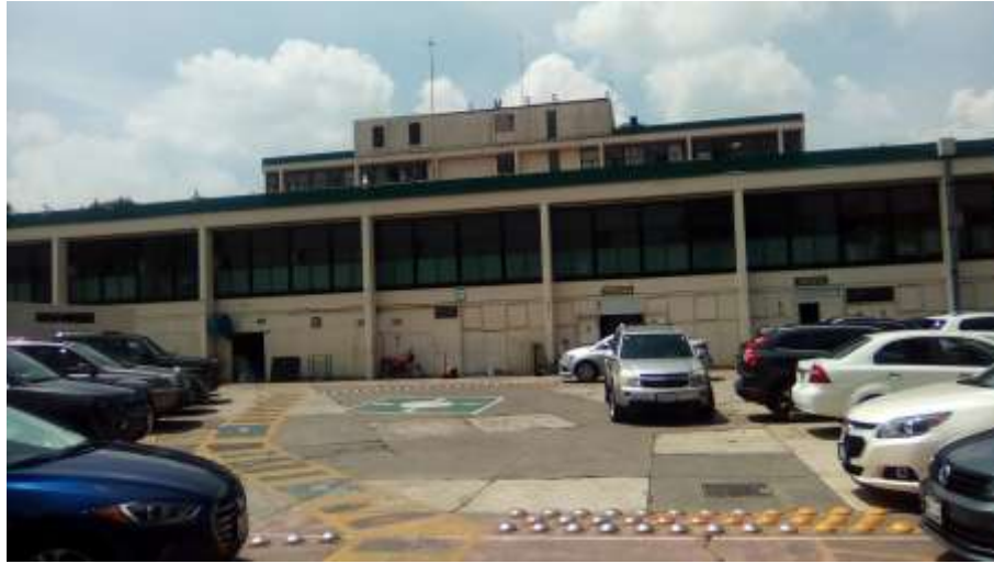
Foto 2. Vista de la Fachada Posterior del Hospital de Gineco-Obstetricia No. 221, Dr. Emilio Chuayffet Chuayffet
