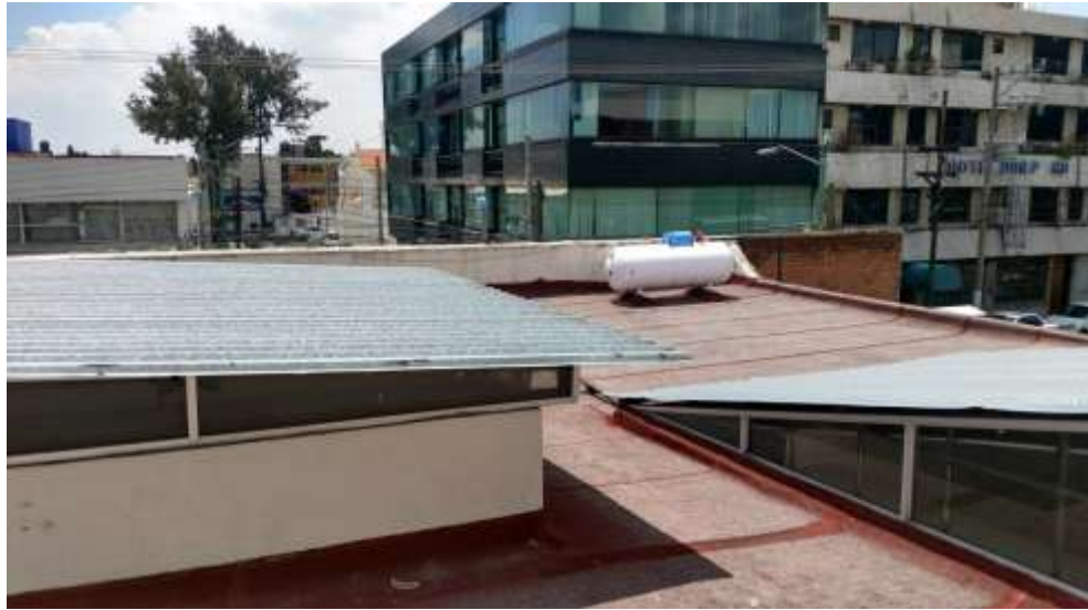
FOTOGRAFIA 5: VISTA DE AZOTEA IMPERMEABILIZADA Y CUBIERTAS LIGERAS
