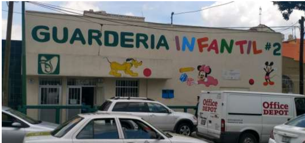
FOTOGRAFIA 1: FACHADA PRINCIPAL DE GUARDERÍA INFANTIL No. 02
