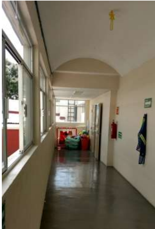
FOTOGRAFIA 7: PASILLO QUE COMUNICA AL ÁREA DE LÁCTANTES
