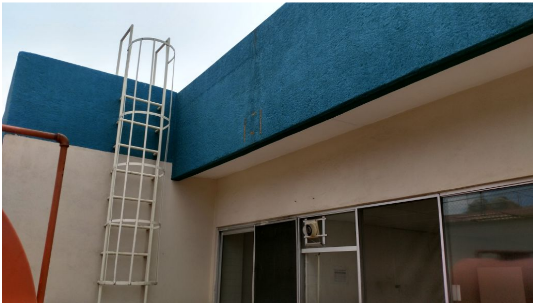
FOTOGRAFIA 4: ESCALERA MARINA DE ACCESO A AZOTEA
