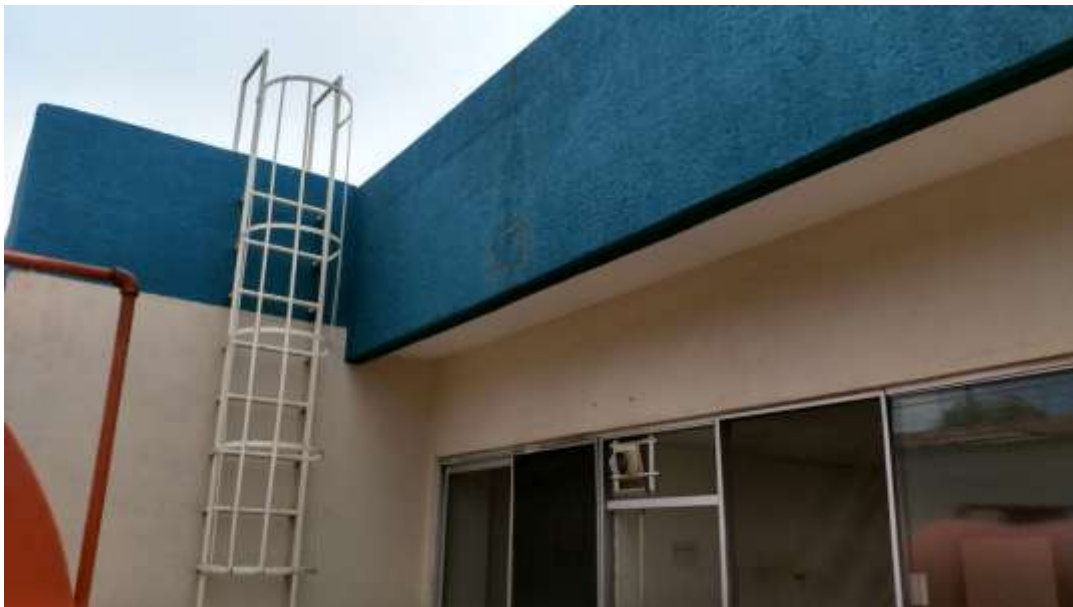
FOTOGRAFIA 4: ESCALERA MARINA DE ACCESO A AZOTEA
