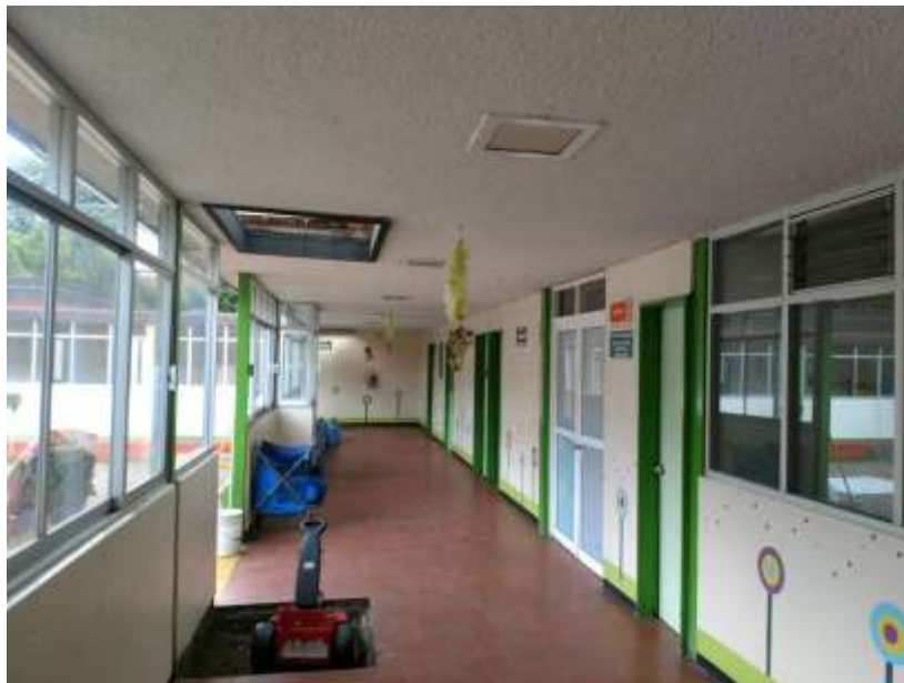
FOTOGRAFIA 13.- PASILLO QUE CONECTA A ÁREA DE COCINA, SEPTICO O PATIO.
