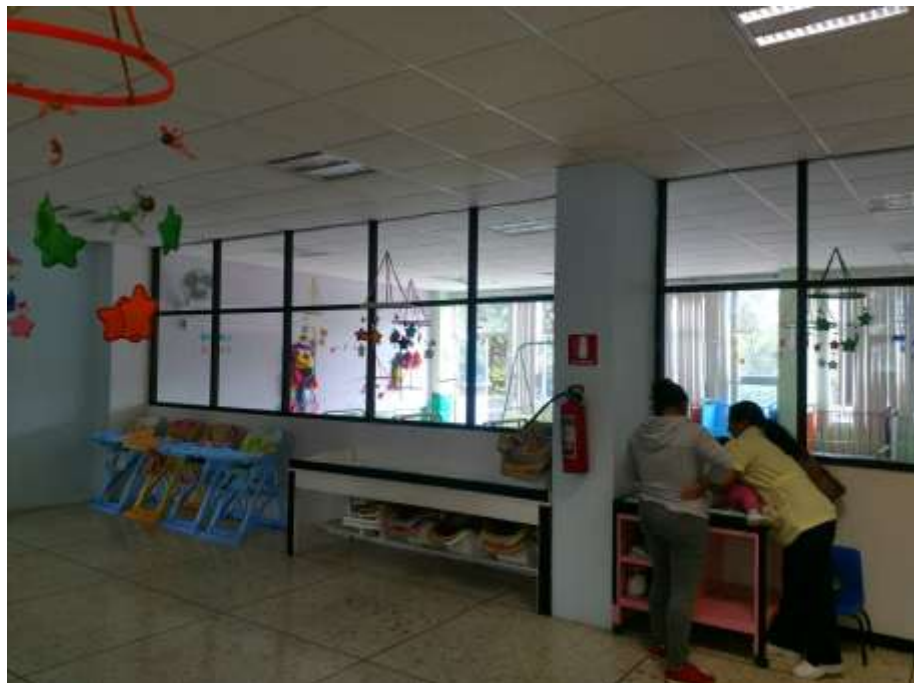
FOTOGRAFIA 23.- VISTA DE PISOS, PLANOES Y CANCELERÍA
