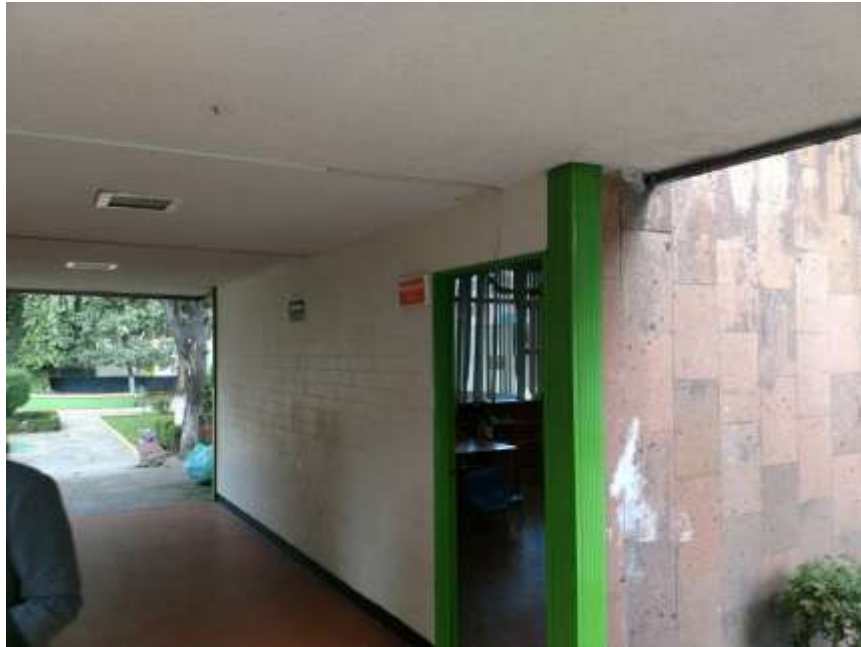
FOTOGRAFIA 9.- ESTRUCTURA A BASE DE MARCOS RIGIDOS
