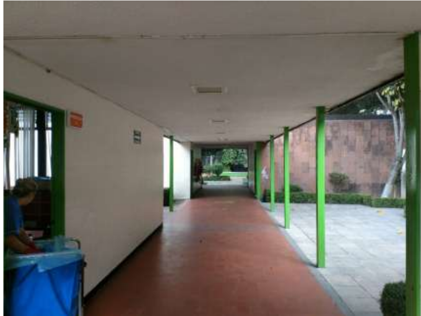
FOTOGRAFIA 10.- ESTRUCTURA A BASE DE MARCOS RIGIDOS
