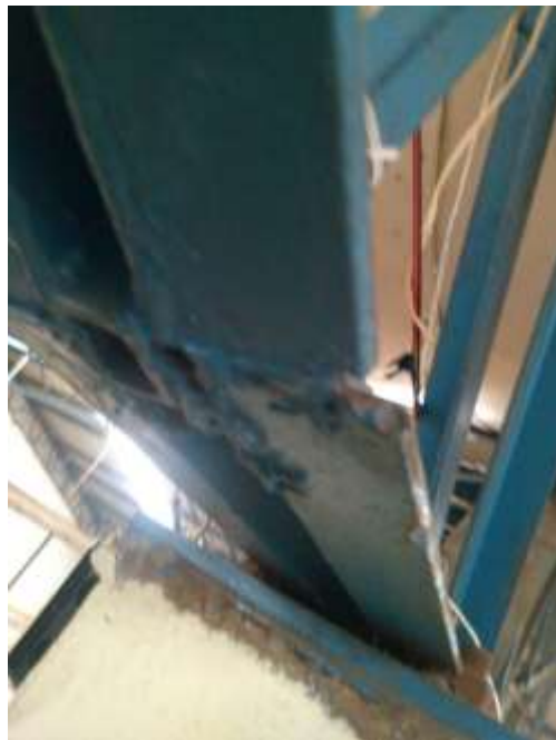
FOTOGRAFÍA 4- VISTA INFERIOR DE LA CUERDA DE UNA DE LAS ARMADURAS.
