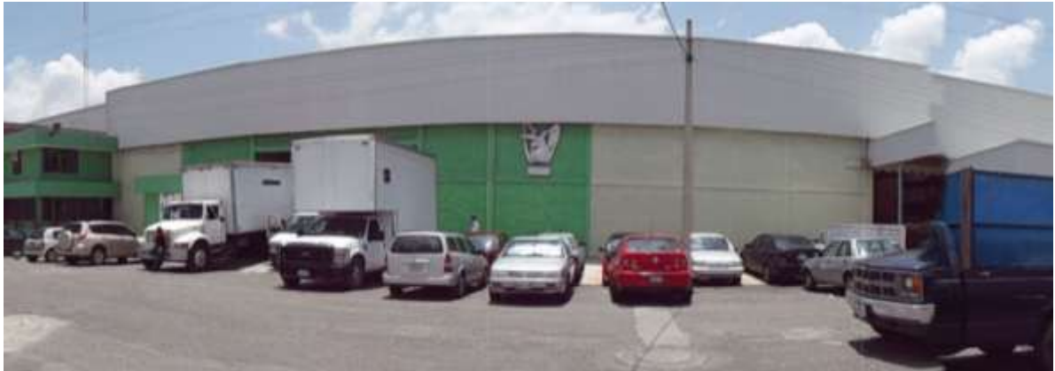
FOTOGRAFÍA 1.- FACHADA PRINCIPAL DEL ALMACÉN DELEGACIONAL DEL IMSS
