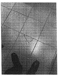
Fisura y fractura de banqueta al interior de la unidad, en el área del estacionamiento.
