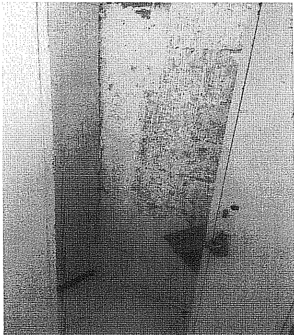
Separación de junta constructiva.
