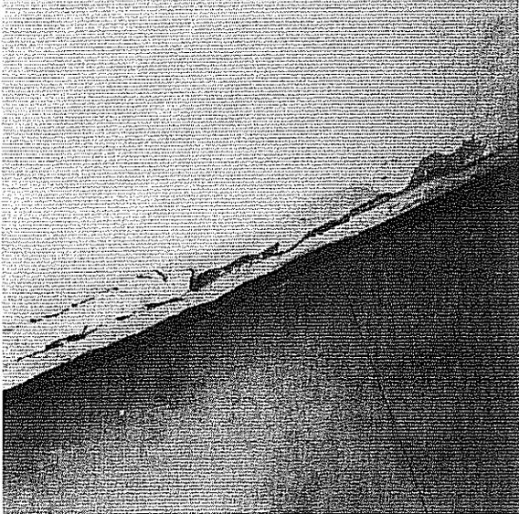
**Prolongación de Fisura en columnas del taller de Conservación.**
