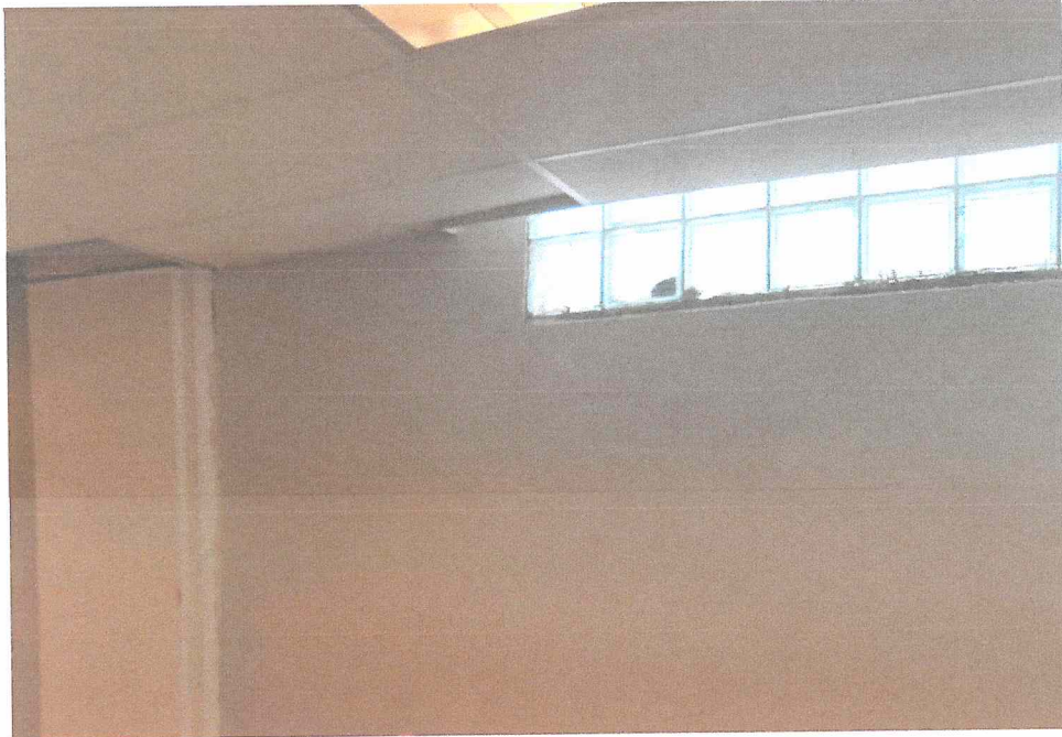
Restitución de piezas de vitrobloc.
