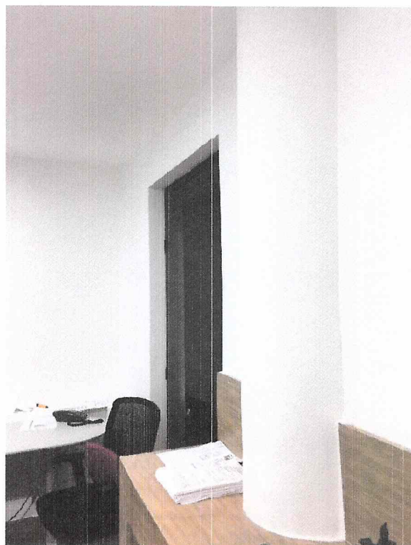
LOS RECUBRIMIENTOS DE ESTRUCTURA A SIMPLE VISTA NO MUESTRAN ALTERACION ALGUNA
