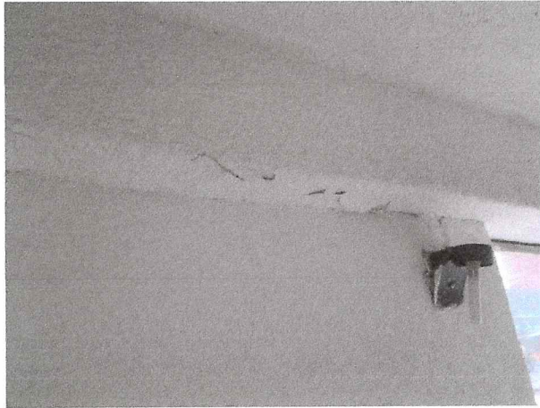
FISURAS SIN DAÑO ESTRUCTURAL
