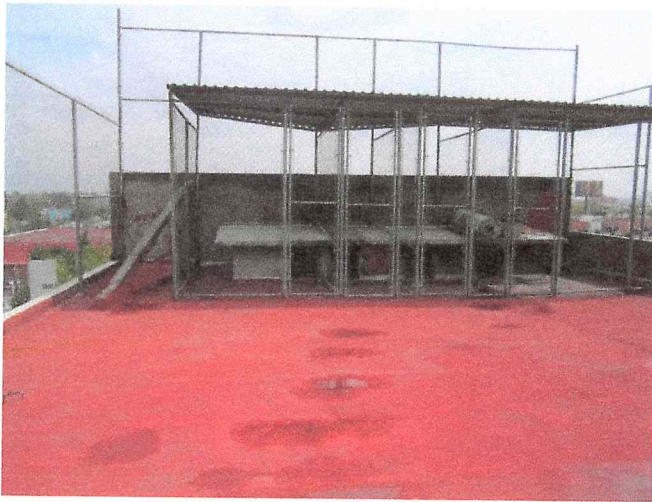
SIN DAÑO ESTRUCTURAL
