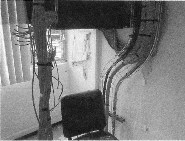
FISURAS SIN DAÑO ESTRUCTURAL
