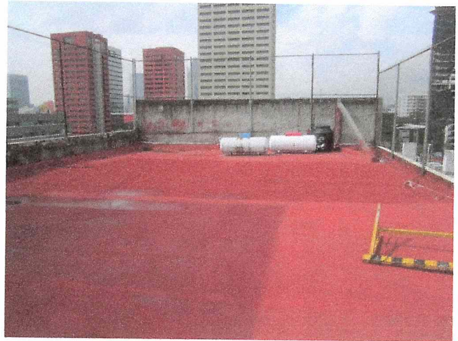
SIN DAÑO ESTRUCTURAL
