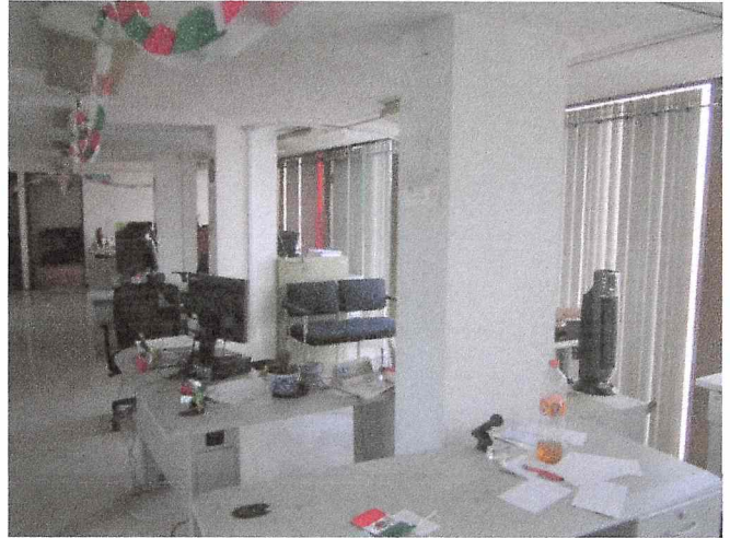
FISURAS SIN DAÑO ESTRUCTURAL
