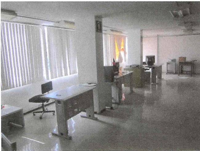
FISURAS SIN DAÑO ESTRUCTURAL
