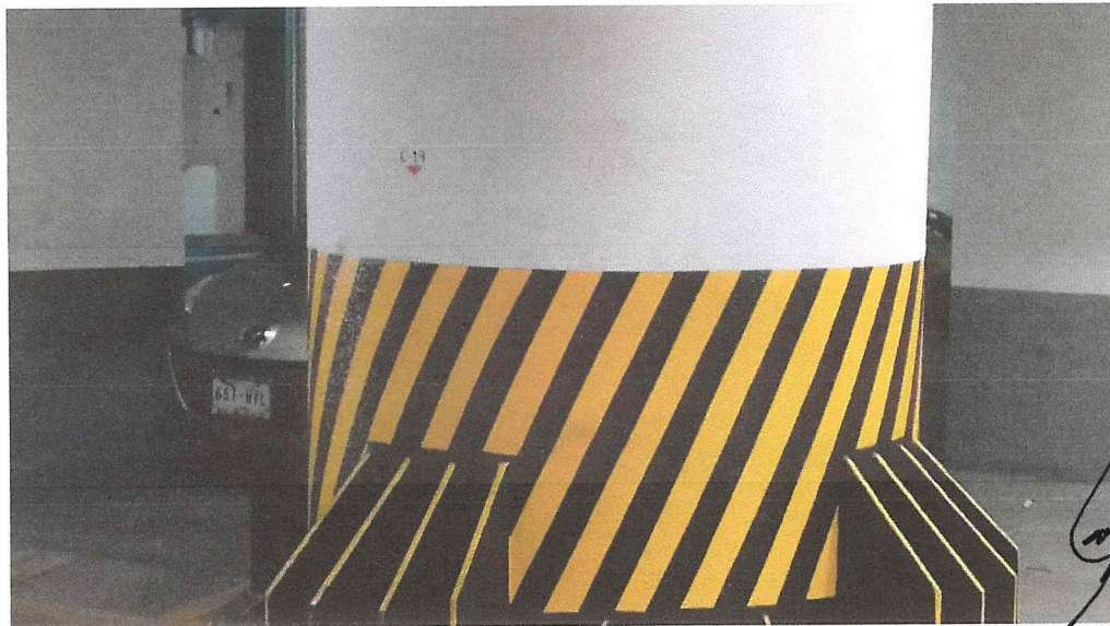
Refuerzo con cartabones en columna de concreto reforzado en planta sótano (después del sismo de 1985).
