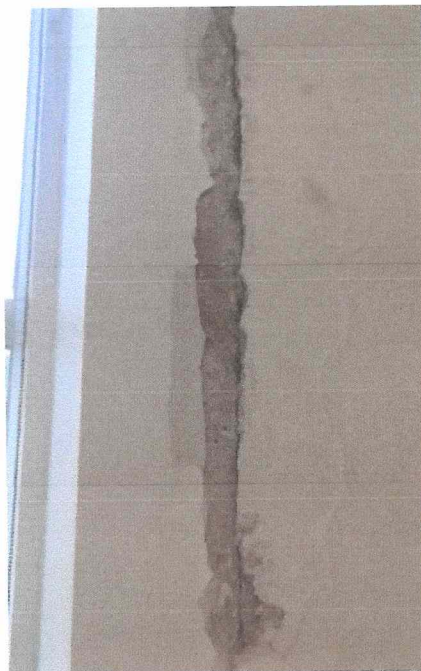
Separación debida a junta constructiva entre castillo y panel de tablaroca.
