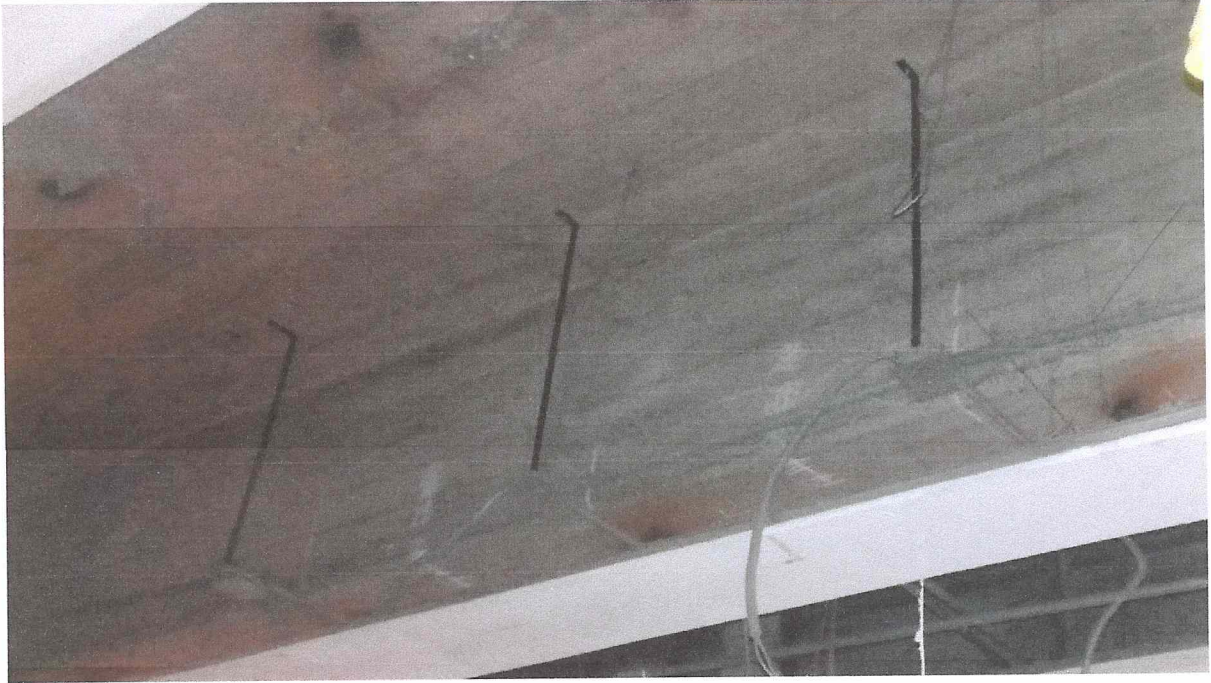
Elementos estructurales como trabes de concreto no presentan daño.
