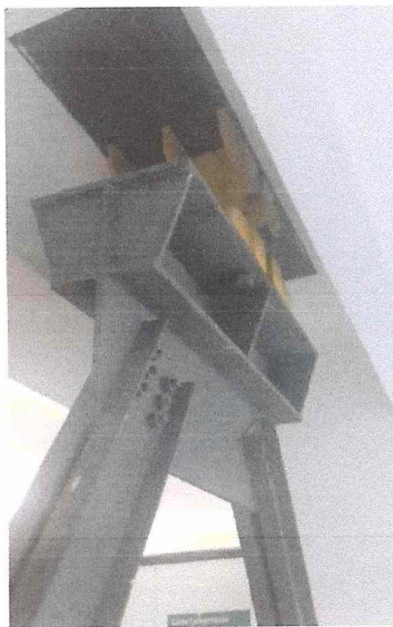
Disipadores de energía en contraventeos colocados en todos los niveles del edificio.
