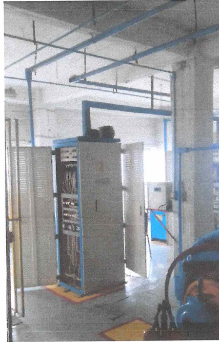
Cuarto de máquinas en azotea con estructura de concreto reforzado aparente.
