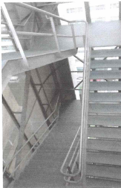
Escaleras de emergencia construidas después del sismo de 1985, estructura metálica anclada a elementos existentes.
