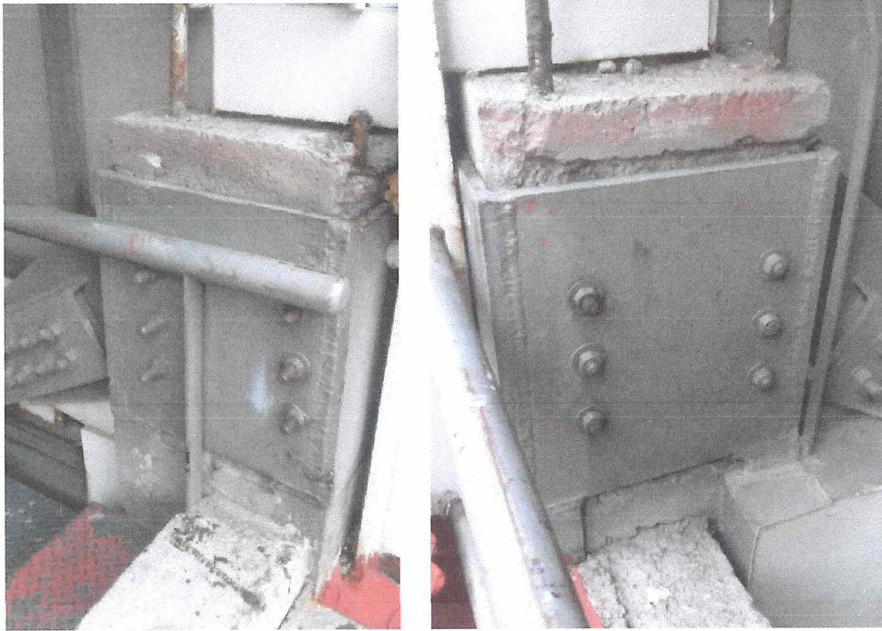
Conexión de escalera de emergencia a columna de concreto existente en planta de azotea.
