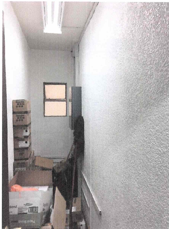
LOS MUROS Y PLAFONES ASÍ COMO LAS INSTALACIONES DE LAS ÁREAS DE GUARDA SE ENCUENTRAN EN BUEN ESTADO
