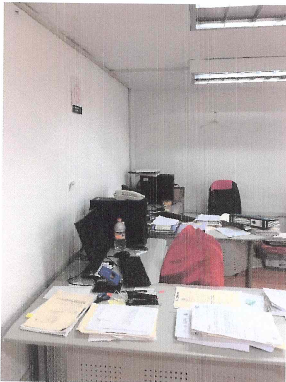
LAS ÁREAS ADMINISTRATIVAS PRESENTAN MUROS Y PLAFONES SANOS
