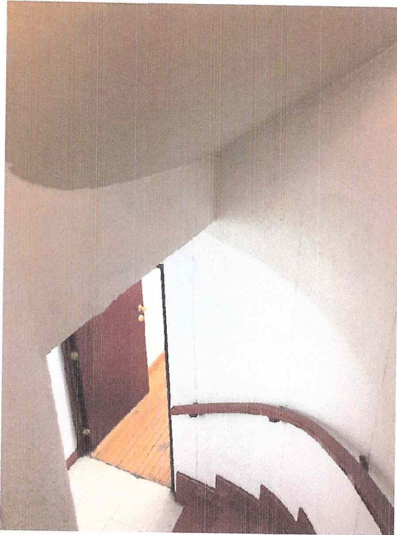
A SIMPLE VISTA LAS ESCALERAS NO PRESENTAN DAÑO ALGUNO, NI EN RAMPAS, NI ESCALONES ASÍ COMO EN LOS MUROS Y PLAFONES LOS CUALES SE MUESTRAN SANOS
