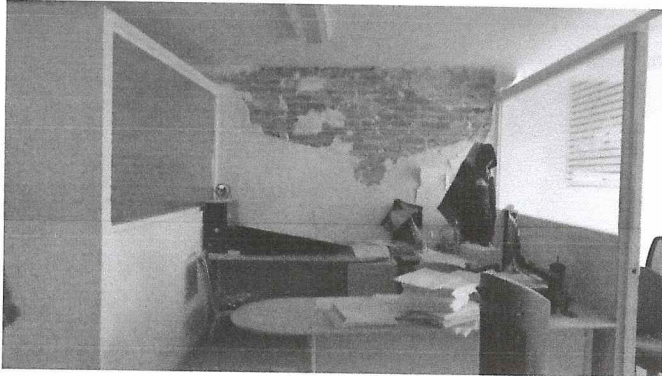
Nivel 5, muros presentan desprendimientos en acabados.
