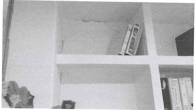
Nivel 5, muros presentan desprendimientos en acabados.
