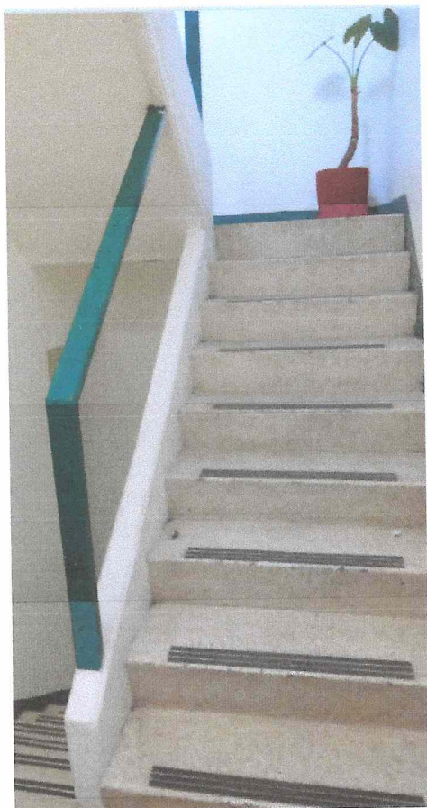
AREA DE ESCALERAS
