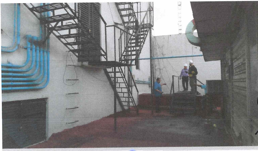
AREA DE AZOTEA
