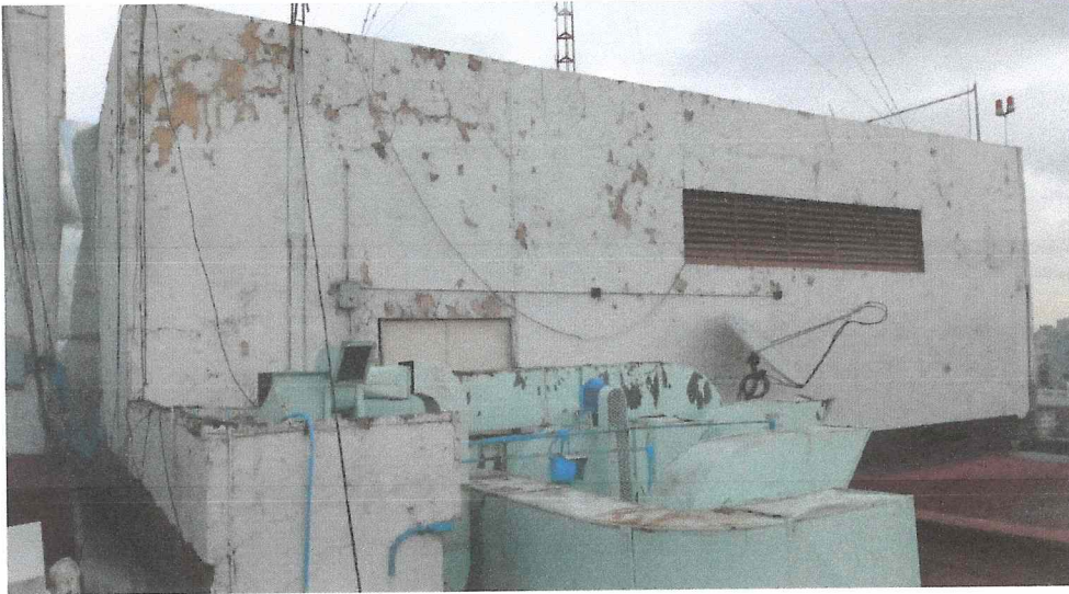
CUARTO DE MAQUINAS EN AZOTEA
