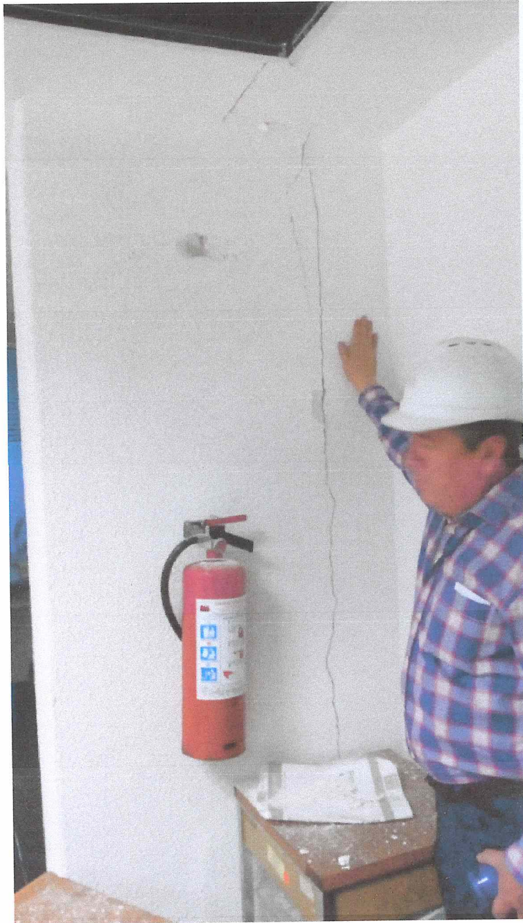
FISURAS ENTRE TABLAROCA Y COLUMNAS DE CONCRETO
