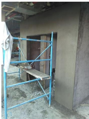
**Se observa el aplanado fino en muro de baños en el eje 12 entre a y b**
