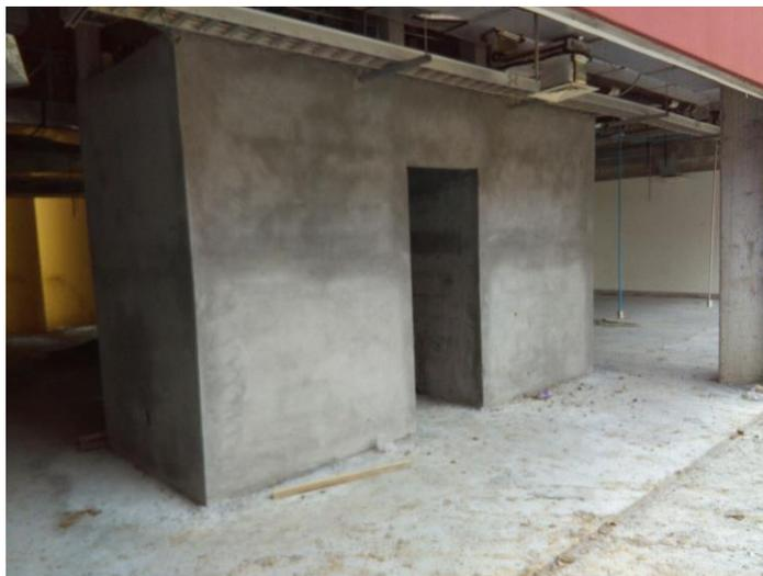
**Se observa el aplanado en muro fino entre los ejes 6 y 8**
