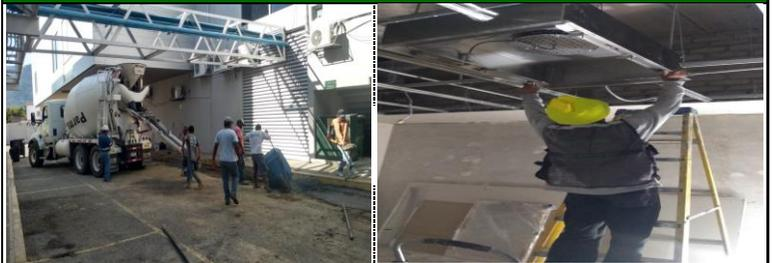
Reposicion de concreto premezclado 1 C-250 kg/cm2 en cepa de la alimentación de Media Tensión. Área de Subestación de la Unidad.
