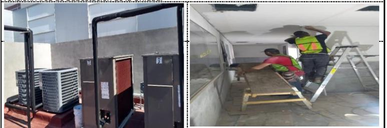
Colocacion de tubería de cobre tipo L de 3/8" y 5/8" de diámetro y forro de neopreno. (armaflex de 1/2" pulgaa de espesor.
