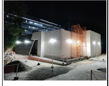
Se colocaron las luminarias exteriores en las 4 fachadas del edificio.
