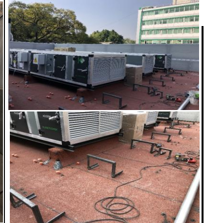
Habilitado de bases metálicas para soporte de tuberías en azotea. Diversas instalaciones : electrica, control hvac, plomería, etc...
