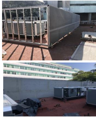
Colocación de Durock para pretil en azotea.
