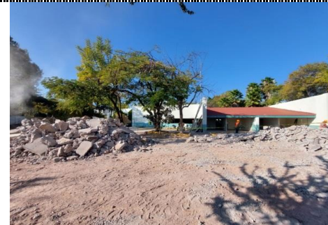
Albergue.- Demolición de elementos existentes en el área en que se desplantará el edificio
