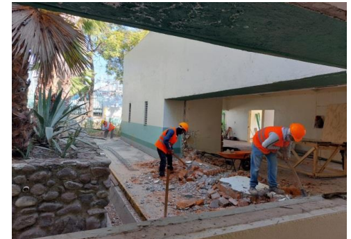
Consulta Externa- demolición de muro de tabique de 6 a 28 cm de espesor con cadenas, castillos con recubrimiento y corte de varilla.
