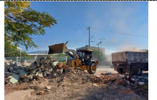
Albergue.- acarreo en camión de material producto de las demoliciones
