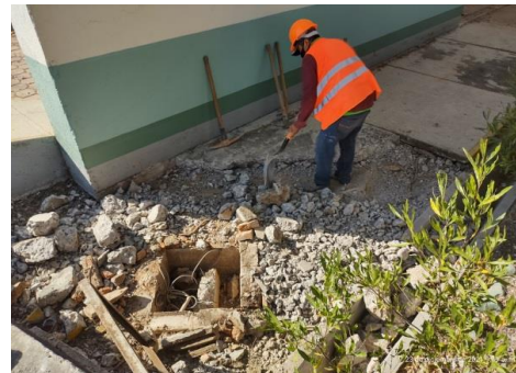
Consulta Externa- demolición de banquetas
