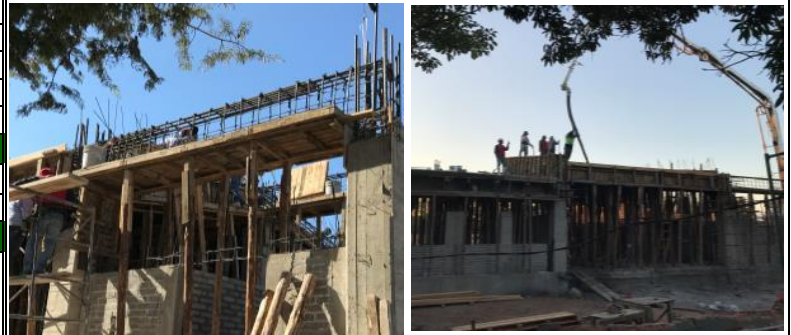
Armado y cimbra de contratrabe en cocina
