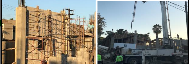
Muros y columnas de dormitorios hombres
